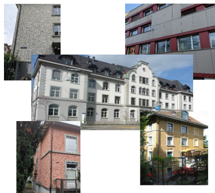
5 der 7 Standorte der GHG HPS St.Gallen
